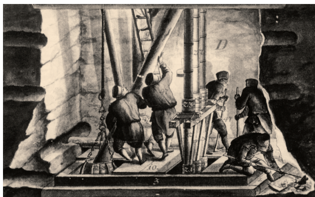
Franc Anton Steinberg: Delo jamskih tesarjev v jašku, 1739 (Zbornik Idrijski rudnik skozi stoletja, 1990).
